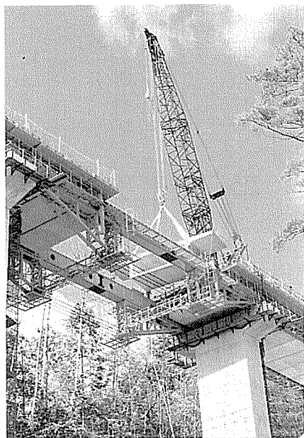
写真-1 架設ガーダーへのセグメント載荷状況
