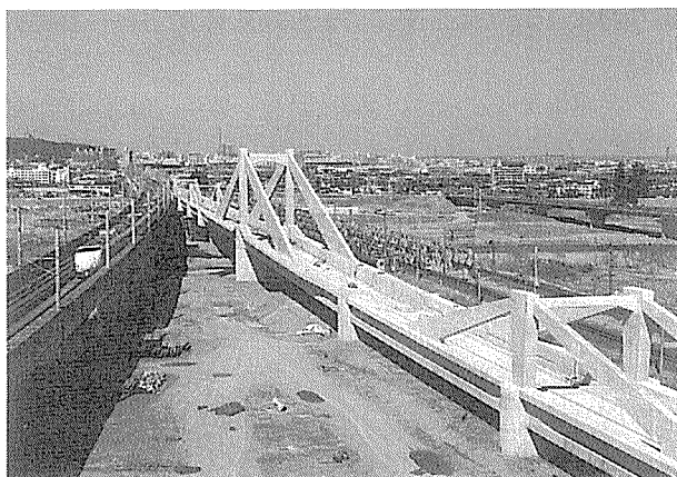
写真-1 名取川橋梁
