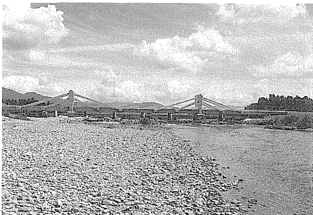
写真-2 第1玉川橋梁
