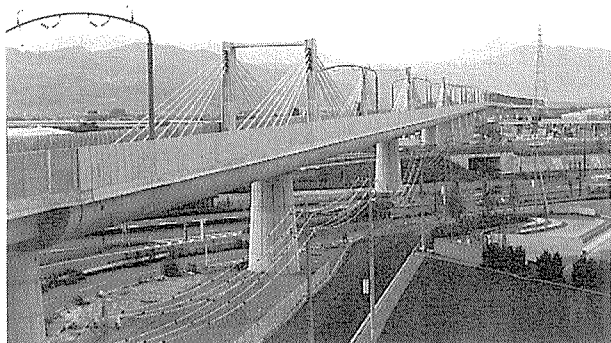
写真-4 屋代南橋梁
