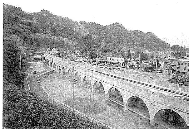
写真-5 武蔵五日市高架橋
