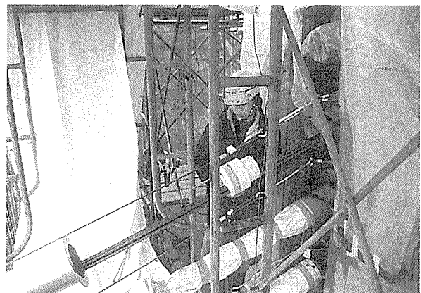
写真-6 ストランド挿入状況（サドル出口部）
