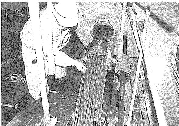
写真-5 ストランド挿入状況（主桁定着体）
