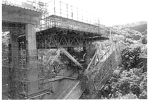
写真-3 補剛桁
