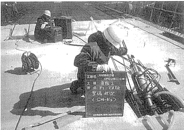
写真-8 床版ケーブル緊張状況
