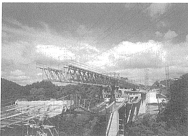
写真-5 主桁架設状況
