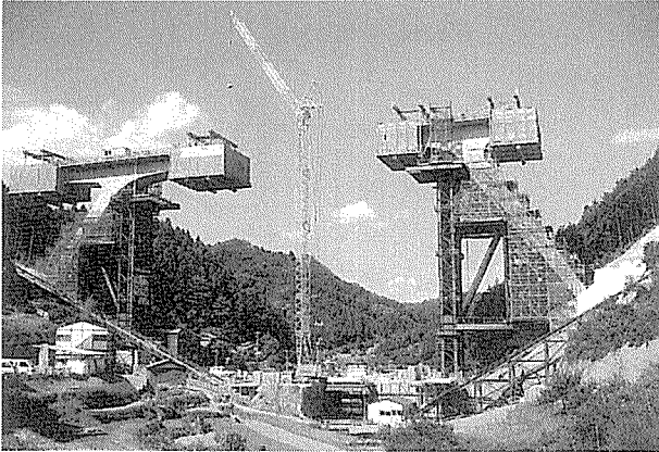
写真-3 張出し架設状況
