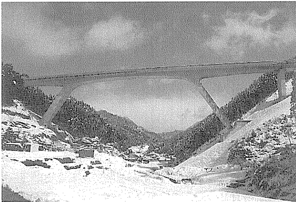
写真-1 舞鶴1号橋(方杖ラーメン橋部)
