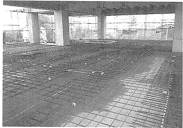
写真-6 2階床部分の施工
