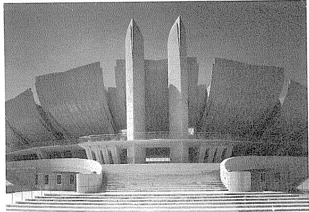
写真-1 スタジアム完成状況
