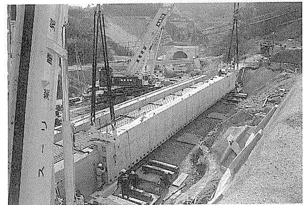
写真-7 桁架設状況
