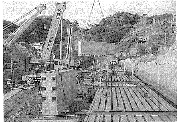
写真-5 プレキャストブロック桁吊込み状況
