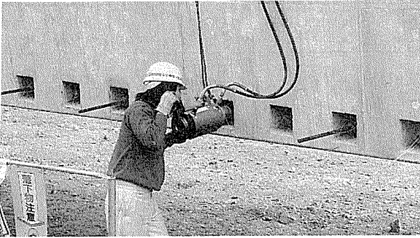
写真-11 横方向鋼材緊張状況
