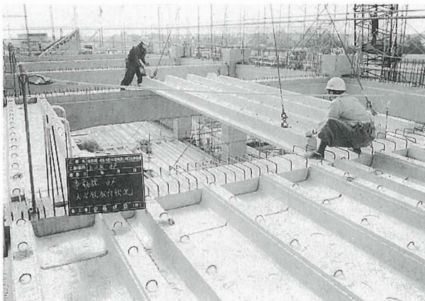
写真-4 KS床板架設
