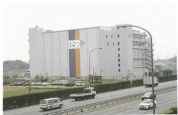
写真-5 完成時全景
