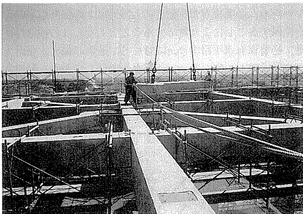
写真-3 PCブレース架設
