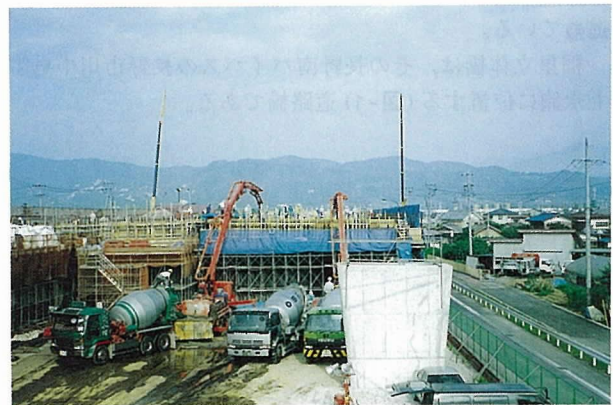
写真-1 ポンプ車設置状況
