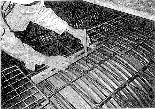
写真-7 変位量測定状況(鉛直方向)
