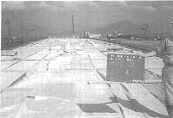
写真-3 養生状況
