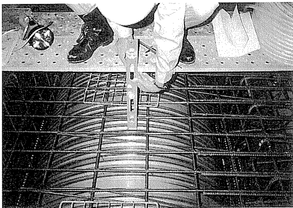
写真-8 変位量測定状況(水平方向)
