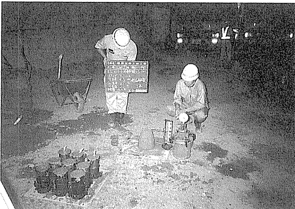
写真-5 スランプ測定状況
