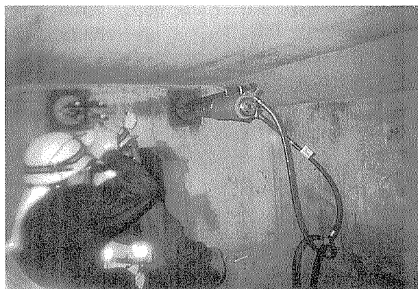
写真-8 緊張状況
