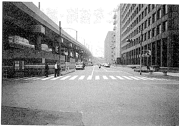
写真-9 仮設橋脚柱撤去後の状況
