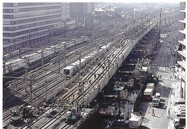
写真-5 桁移動完了時
