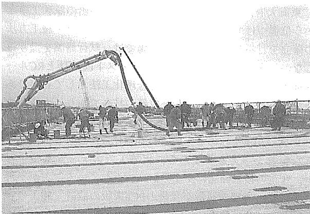
写真-10 コンクリート打設状況
