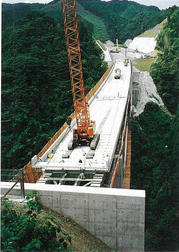
写真-2 クローラークレーンによる床版架設(桜樹橋)
