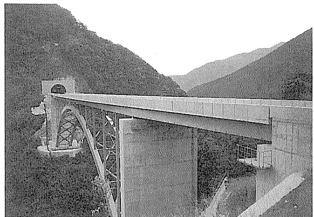
写真-4 桜樹橋 施工完了
