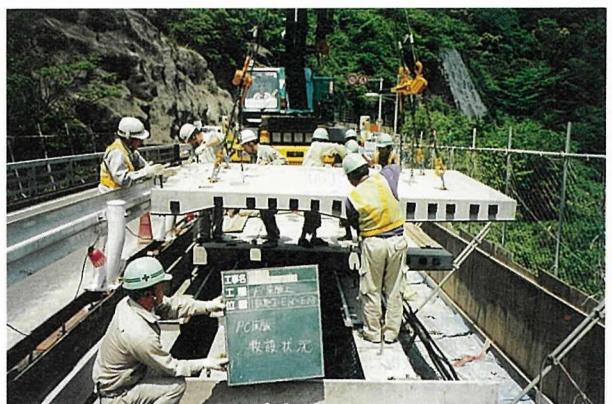
写真-3 プレキャスト床版敷設状況
