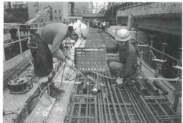
写真-4 鉄筋の熱間押抜き圧接
