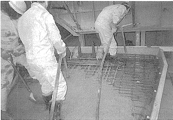
写真-6 コンクリート打設状況
