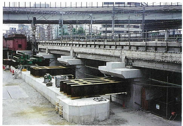
写真-3 仮橋脚設置状況
