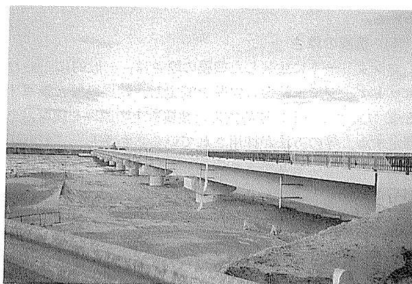
写真-2 主げた塗装後の岩城アイランドブリッジ
