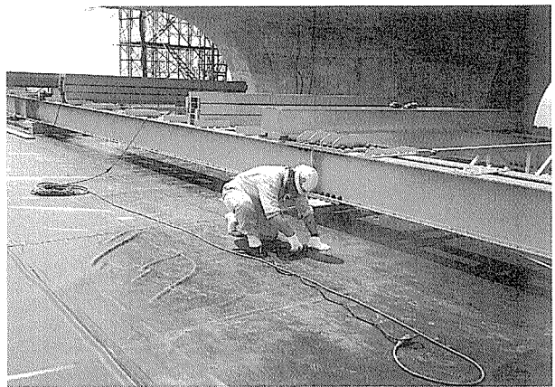
写真-7 防水シート敷設
