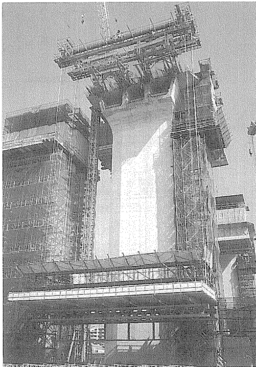
写真-6 作業床リフティング
