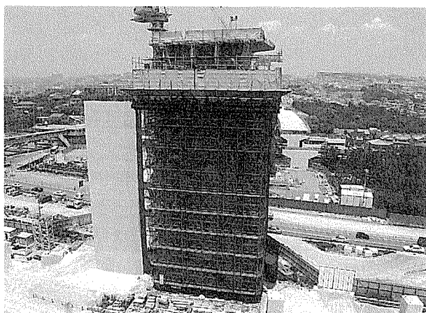
写真-4 柱頭支保工
