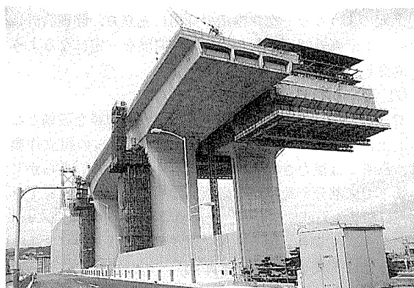
写真-5 片持ち張出し施工
