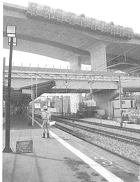
写真-8 壁高欄の施工 (JR上空)
