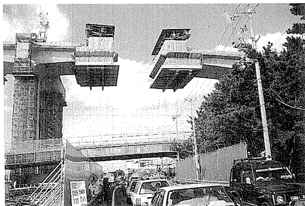
写真-9 ワーゲン移動(国道2号上空)
