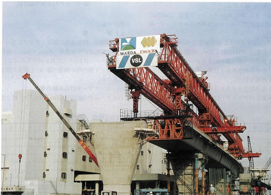
写真-3 移動式架設桁
