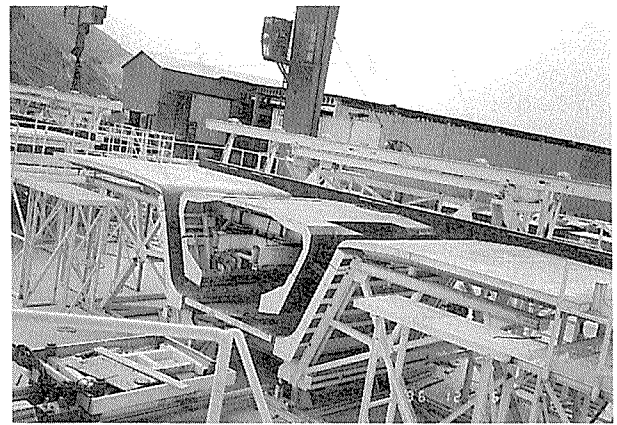
写真-1 セグメント製作用型枠
