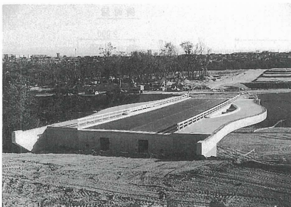
写真-1 播磨中央橋全景(その1)
