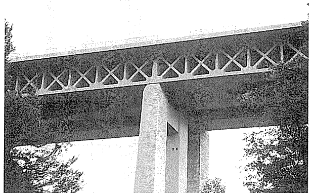
写真-5 マングファール橋 全景-2
