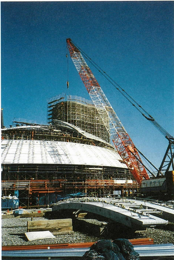
写真-4 PCa板取付け状況(1)
