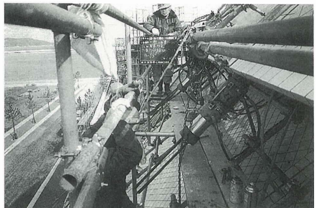
写真-7 プレストレス導入状況(緯線方向)
