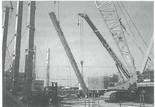
写真-3 PC柱建方状況
