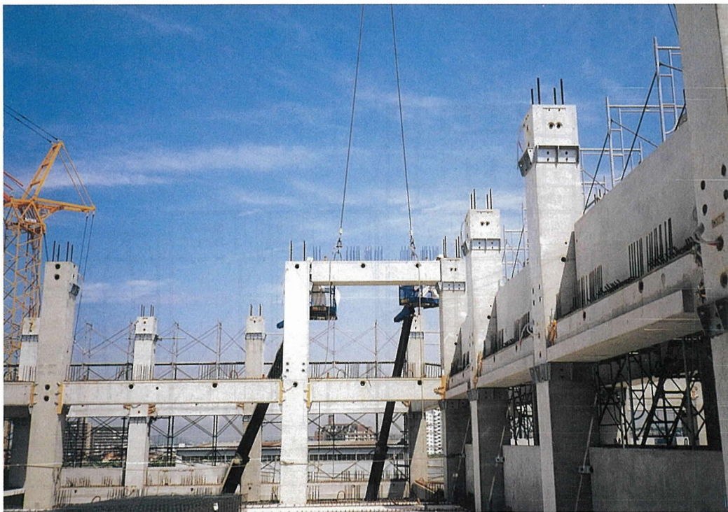
写真-4 PC大梁建方状況
