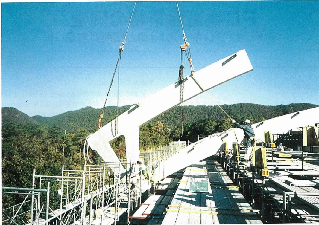
写真-6 北棟アーチ梁架設
