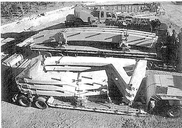
写真-3 アーチ梁運搬状況
