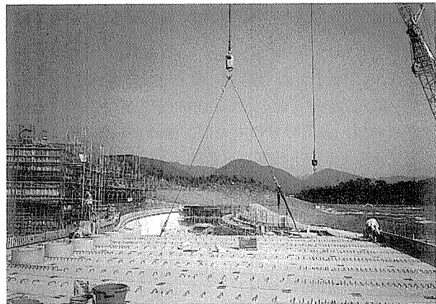
写真-4 南棟ST版架設
