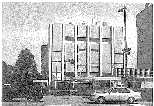
写真-3 (D) 店舗遊技場解体前調査時の外観
