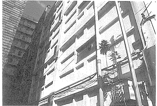
写真-1 (A) 自社ビル解体前調査時の外観
