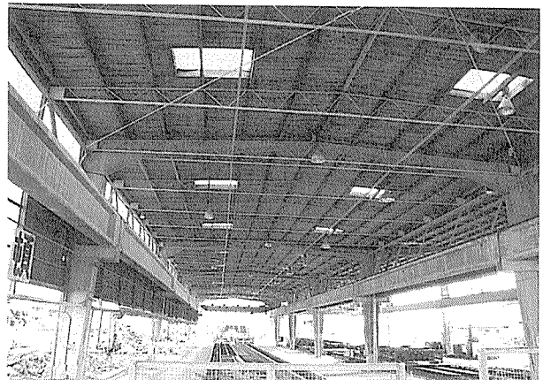
写真-2 (B) 自社工場上屋解体前調査時の内部
