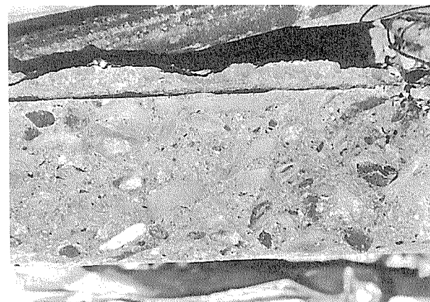
写真-10 (B) PCa. PC梁の中性化試験
