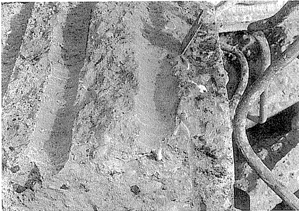
写真-12 (D) 場所打ちPC梁の中性化試験
