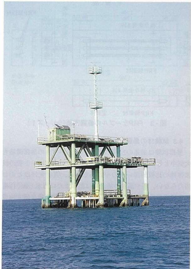
図-2 海洋技術総合研究施設の外観
