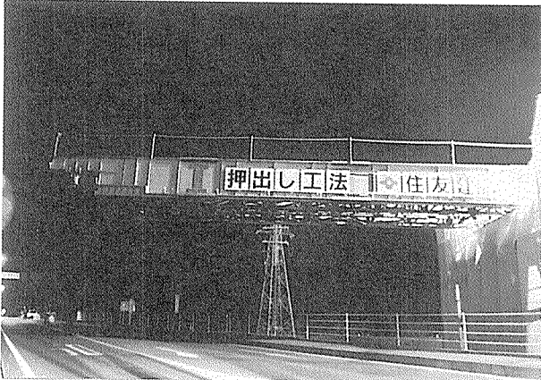
写真-12 夜間押し出し施工
