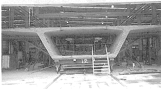
写真-1 ショートライン方式キャストセル
