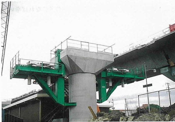
写真-3 Underslung Truss用のブラケット
