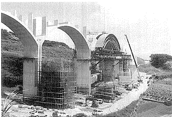
写真-2 セントル工法 (南風原高架橋)
