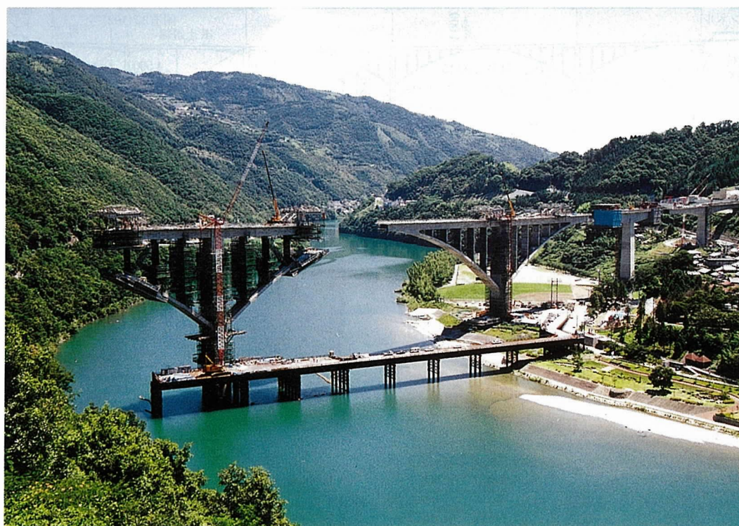
写真-1 工事全景
