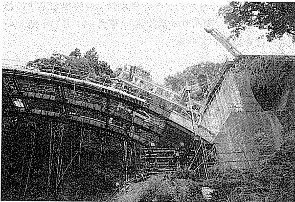
写真-5 移動作業車組立て
