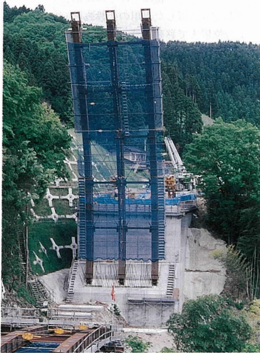
写真-2 鋼管アーチ組立て完了
