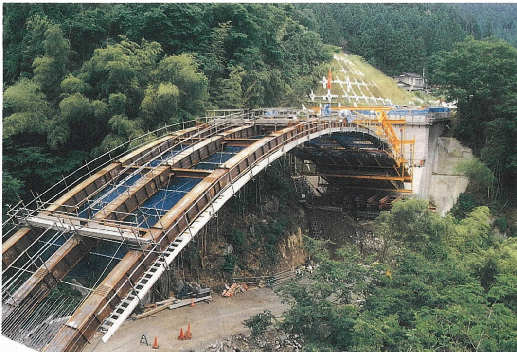
写真-4 閉合完了
