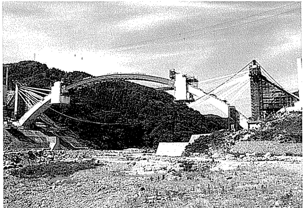
写真-11 メラン連結完了
