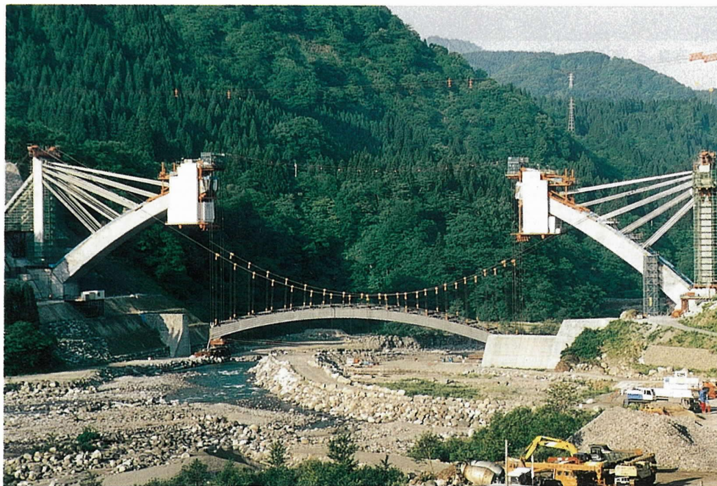
写真-1 メラン直吊り一括架設
