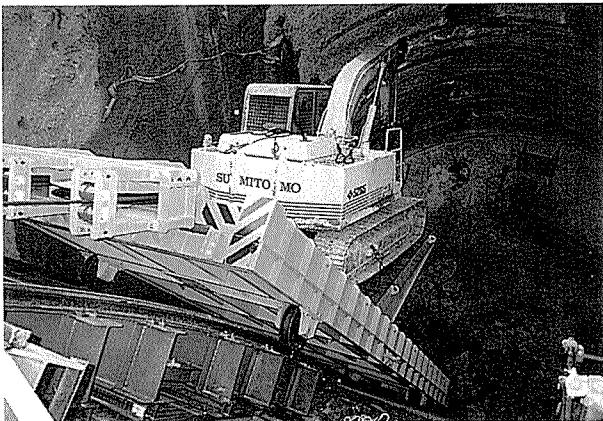
写真-3 インクライン稼働状況
