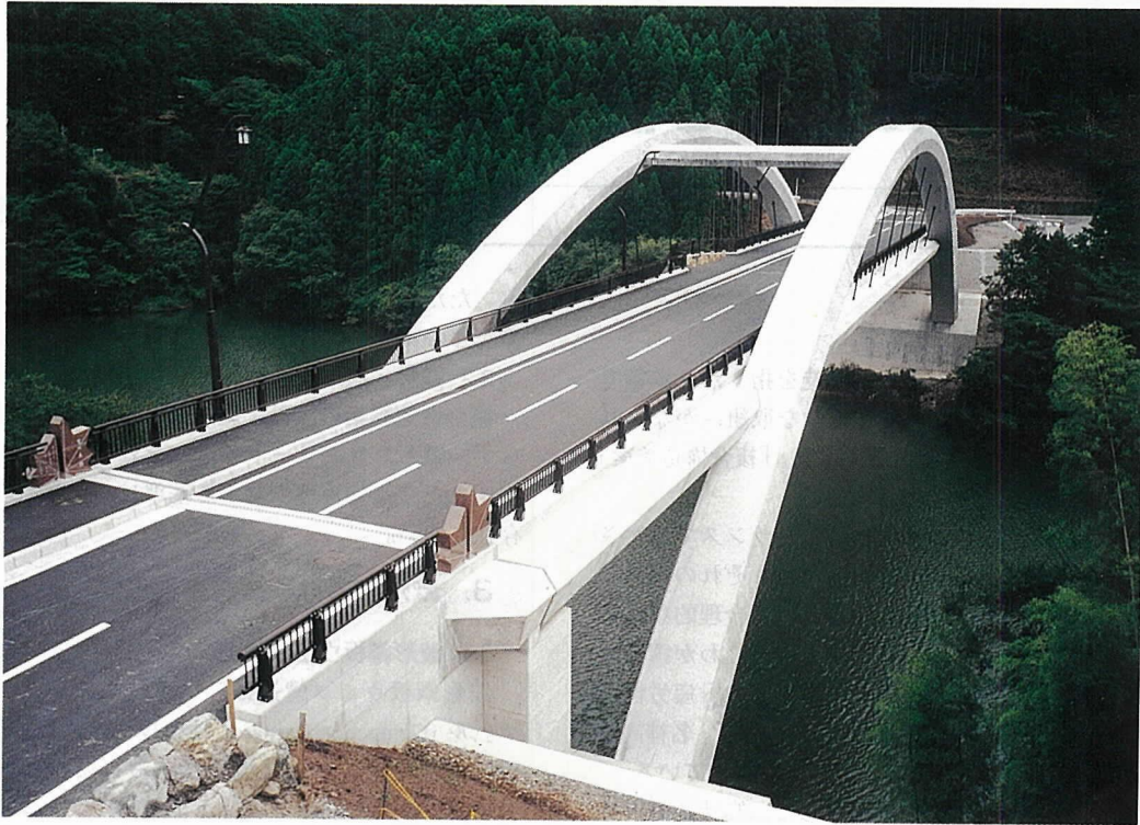
写真-2 完成間近の宮川大橋
