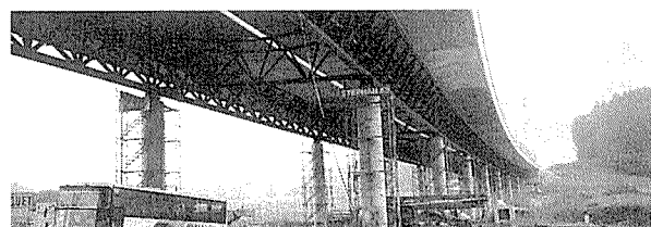
写真-14 ルーリー高架橋
