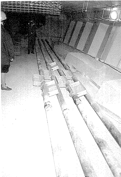
写真-5 ドール橋桁内部
