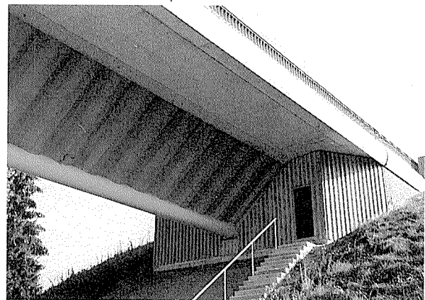
写真-3 モープレ高架橋 橋台部のメンテナンスルーム
