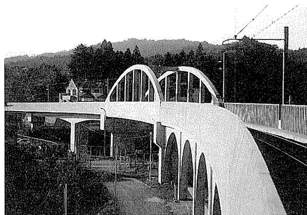
写真-6 武蔵五日市駅架道橋(JR東日本提供)
