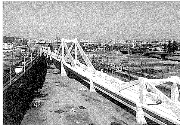
写真-5 名取川橋梁(JR東日本提供)
