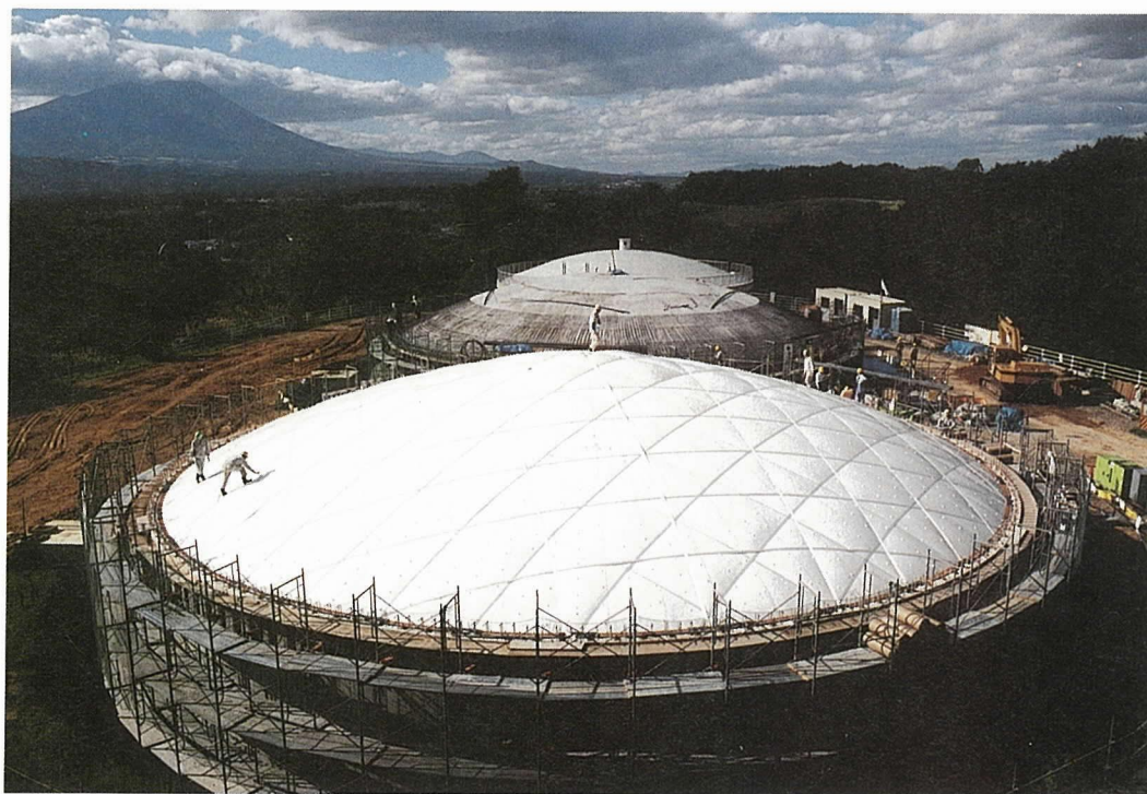
写真-2 空気膜型枠工法
