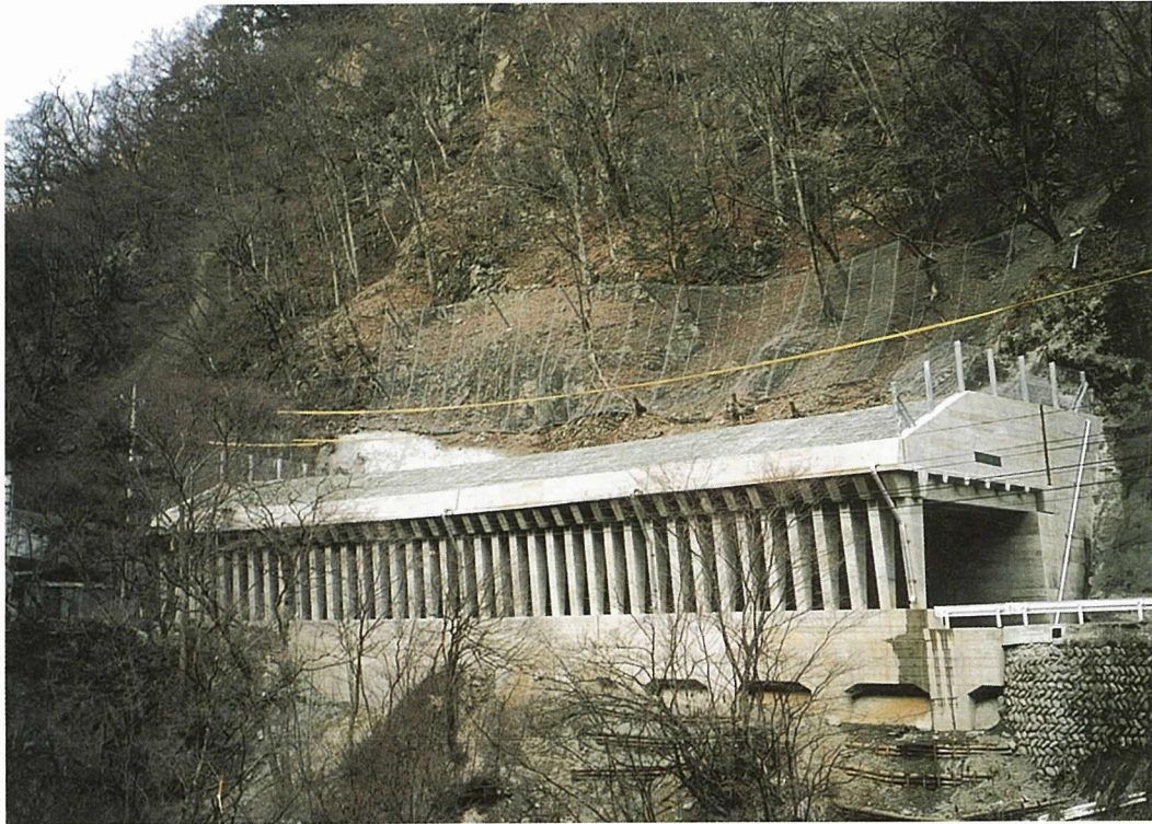
写真-1 ロックシェッドの例
