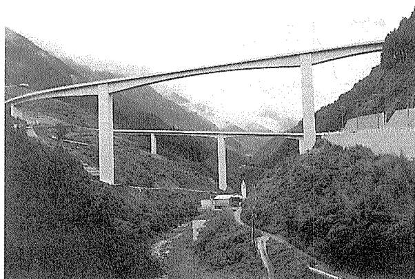
写真-1 滝沢ダムを背景としたループ橋
