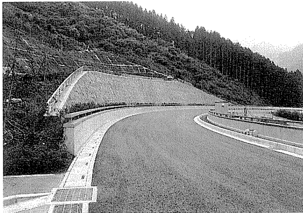
写真-8 土工区間山側の石積み擁壁
