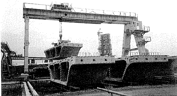
写真-6 門型クレーンによるセグメントの小運搬
