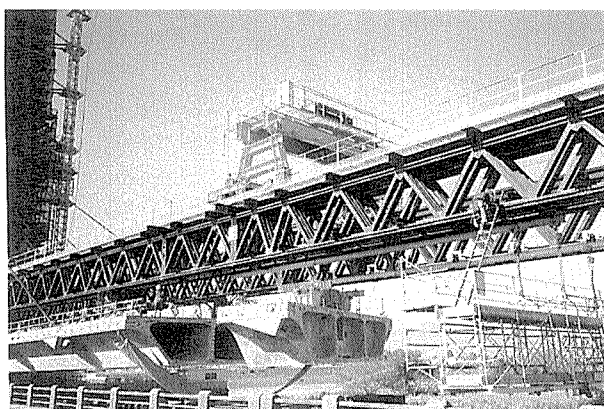
写真-9 エレクションガーダーによるセグメントの架設
