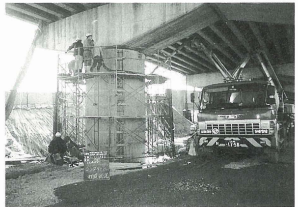
写真-3 1次コンクリート打設状況
