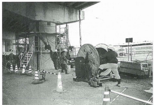
写真-4 PC鋼材挿入状況
