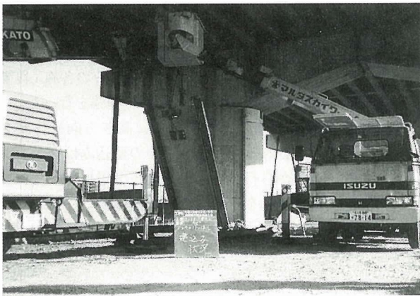
写真-1 パネル建込み状況
