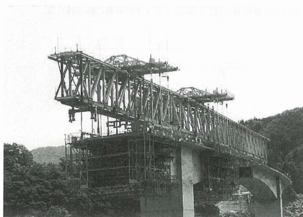
写真-10 張出し架設状況
