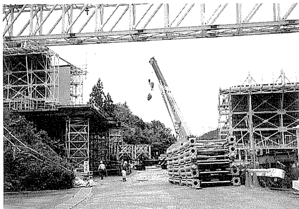
写真-4 型枠の組立て
