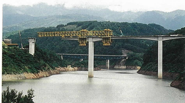
写真-6 径間移動状況
