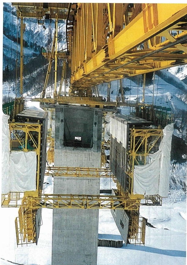
写真-5 型枠装置
