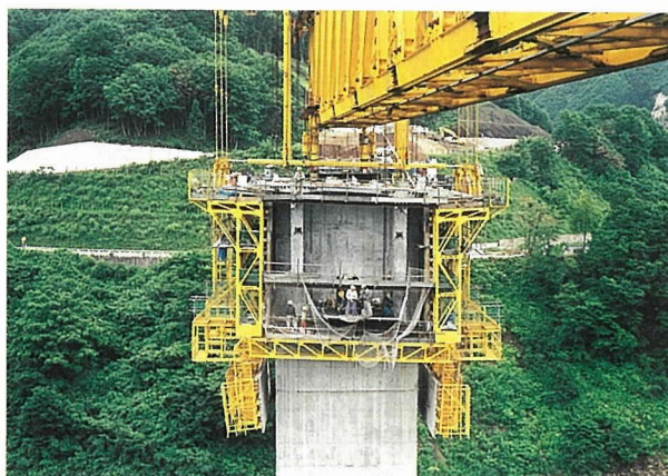
写真-7 柱頭部の施工状況
