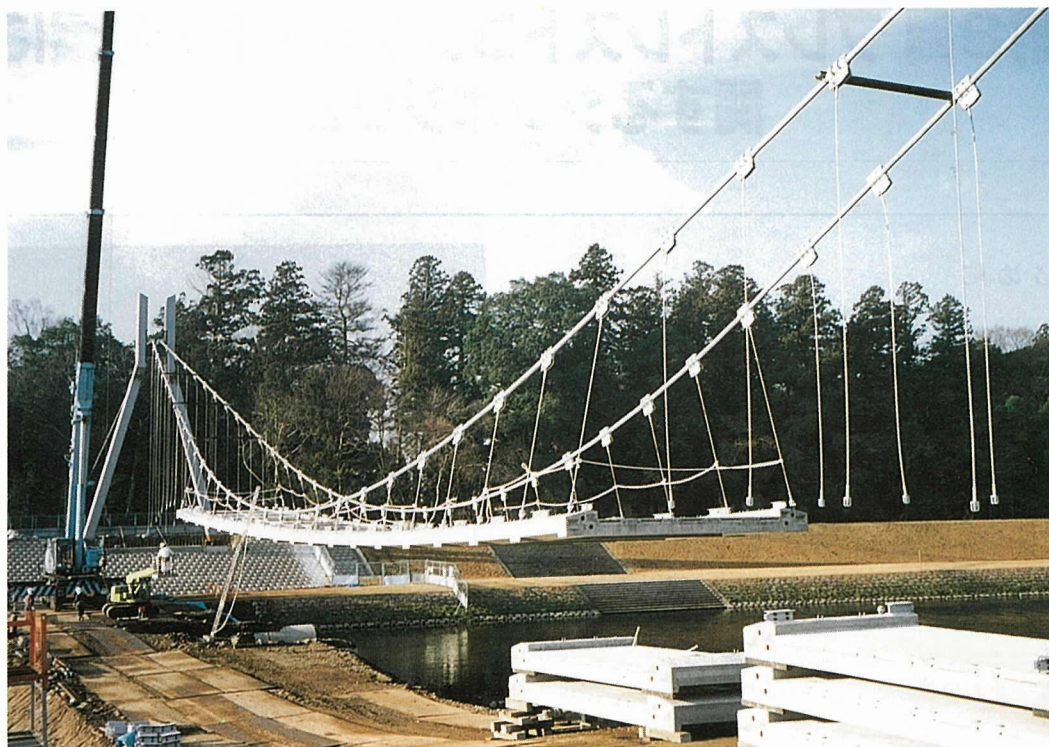
写真-6 床版架設状況
