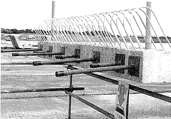
写真-3 プレグラウトPC鋼材によるプレキャスト床版製作状況
