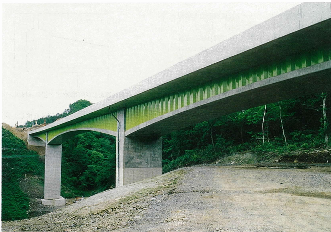
写真-5 波形鋼板ウェブPC橋(本谷橋)
