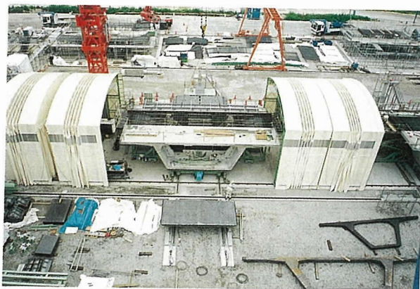
写真-1 セグメント製作状況
