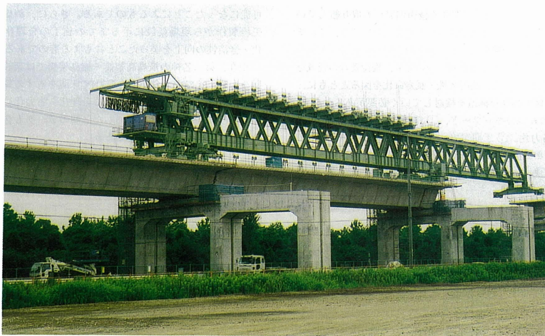
写真-2 スパンバイスパン架設状況
