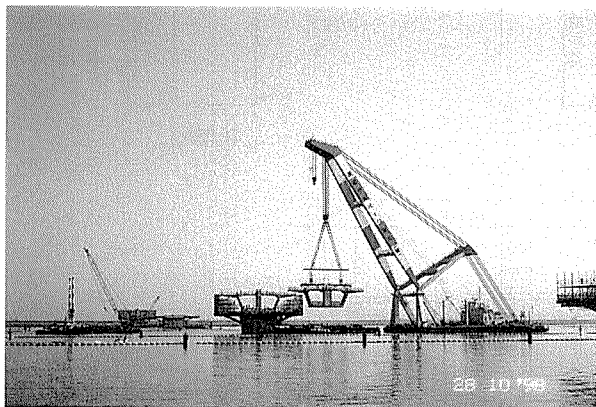
写真-4 柱頭部セグメントFC架設状況
