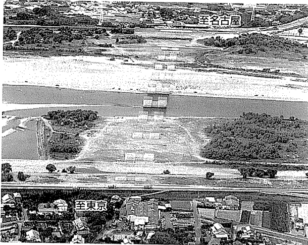
写真-2 現況写真
