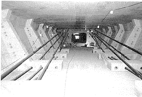
写真-3 外ケーブル配置状況
