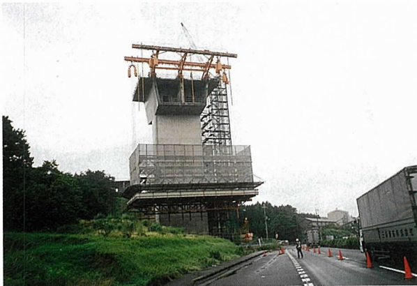
写真-10 作業床リフティング
