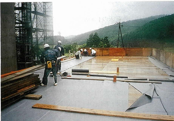
写真-11 防水シート敷設
