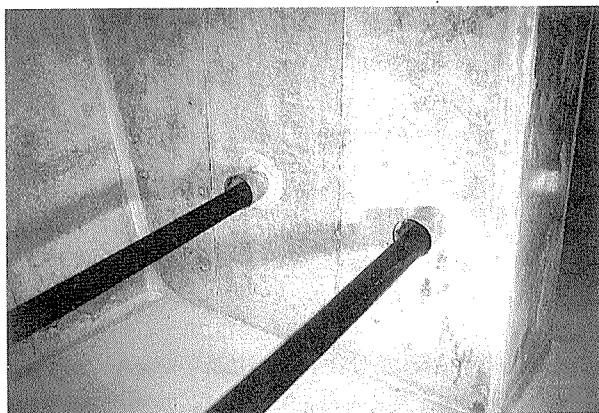
写真-5 外ケーブル偏向部
