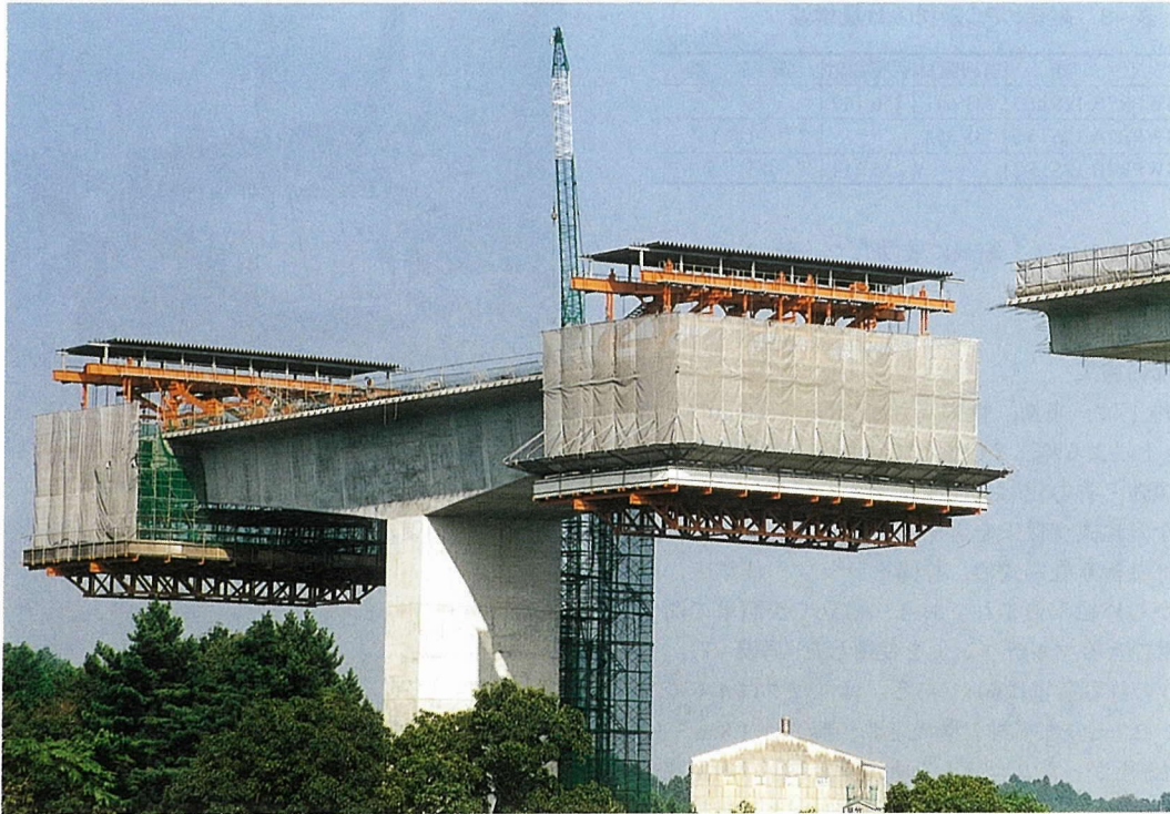
写真-9 片持ち張出し施工
