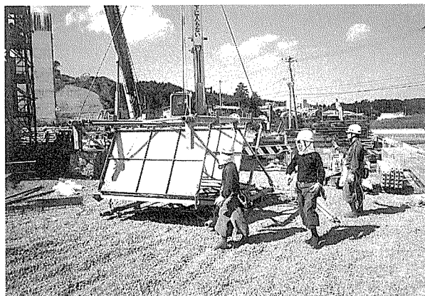
写真-7 マルチベントの組立て
