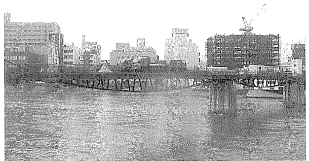
写真-10 載荷試験
