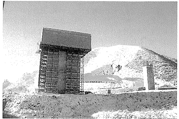
写真-2 柱頭部支保工
