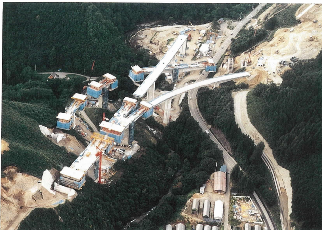
写真-1 橋梁全景(張出し施工中)
