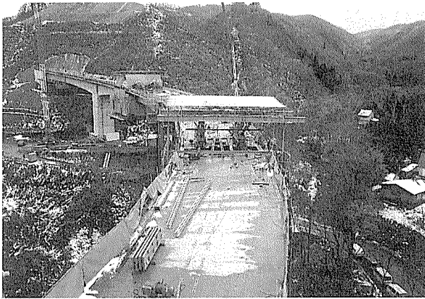
写真-5 急曲線部施工状況
