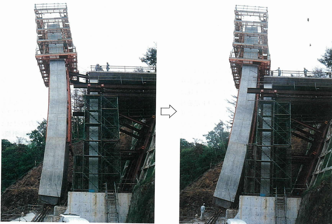
写真-2 アーチリングの引戻し
