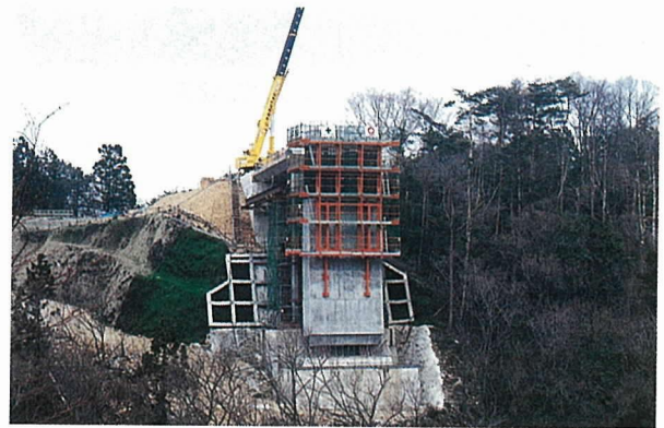
写真-1 クライミングステージの設置
